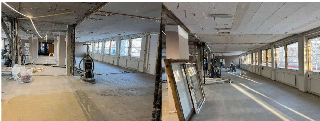
Pågående rivningsarbete och slipning av golv.
